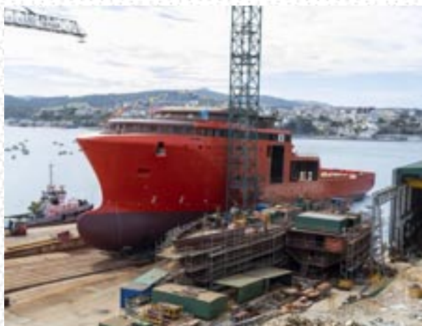
El Østensjø Rederi construye Astilleros Gondan
